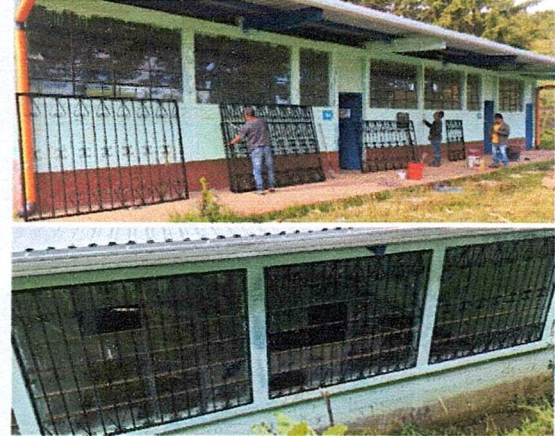
Foto 4: ÁREA DONDE SE ESTÁ MEJORANDO E INSTALANDO BALCONES.
